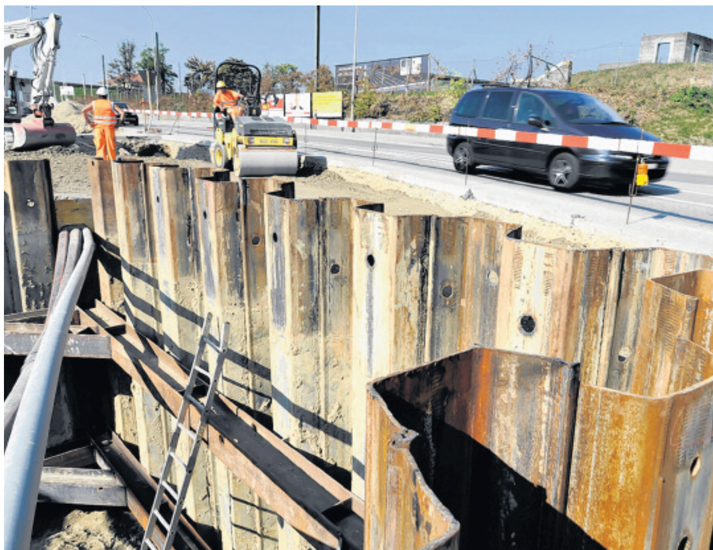
Ein weiterer Schritt im Poya-Projekt: An der Murtenstrasse haben bereits die Vorarbeiten für die Unterführung begonnen. Bild Vincent Murith
